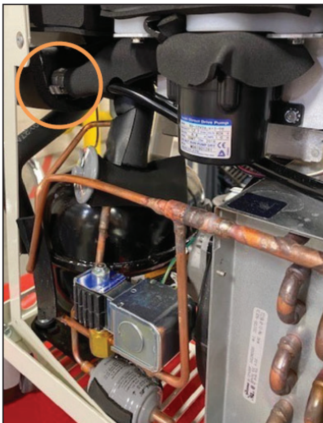
Fig. 8-22 Détachement des deux colliers de serrage (étape 3 - Pompe CC)
