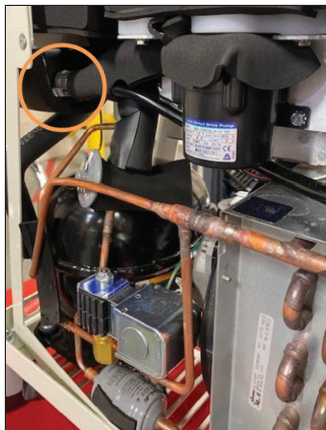
Obr. 8-22 Odpojte dve svorky (krok 3 – čerpadlo na jednosmerný prúd).
