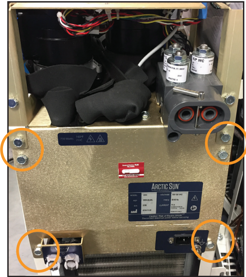
Fig. 8-36 Retire los seis pernos (paso 3)
