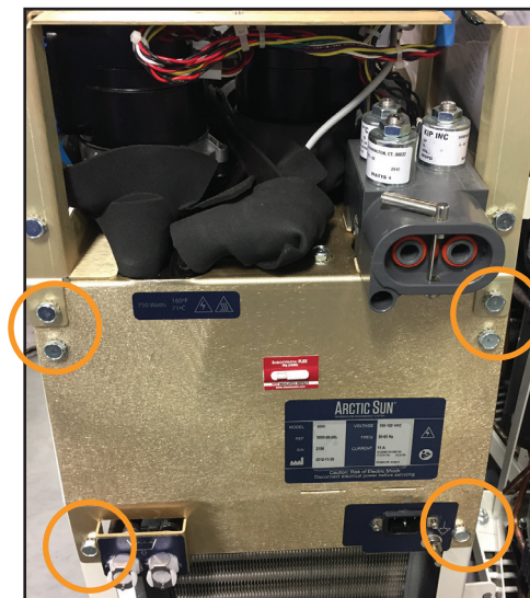
圖 8-36 拆除六個螺栓 (步驟 3)
